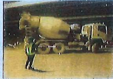
รูปที่ 13 พนักงานให้สัญญาณจราจรในเขตก่อสร้าง
