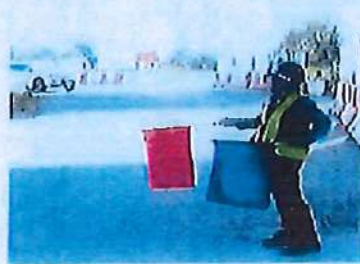
รูปที่ 12 พนักงานให้สัญญาณจราจรในเขตก่อสร้าง
